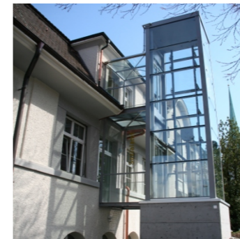
| Aufzug im Betrieb
