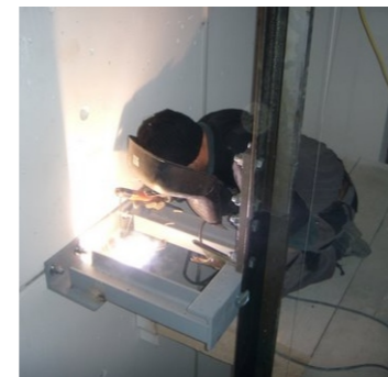
| Schweissarbeiten im Schacht
